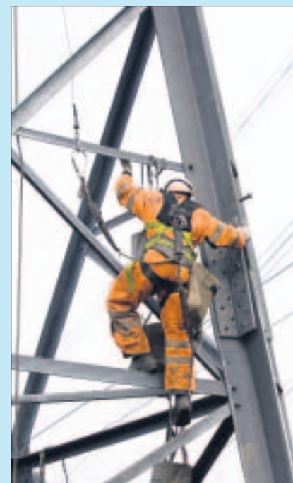
Arbeiter errichten eine Hochspannungsleitung: Auch in Sachsen muss das Netz ausgebaut werden. Foto: imago
